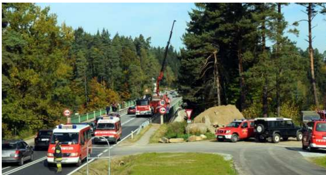
Von der Staasebrücke wurden die Ölsperren ins Wasser verbracht
