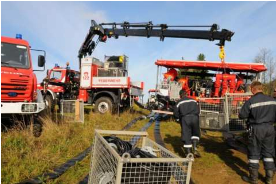
Die Großpumpen werden in Stellung gebracht...
