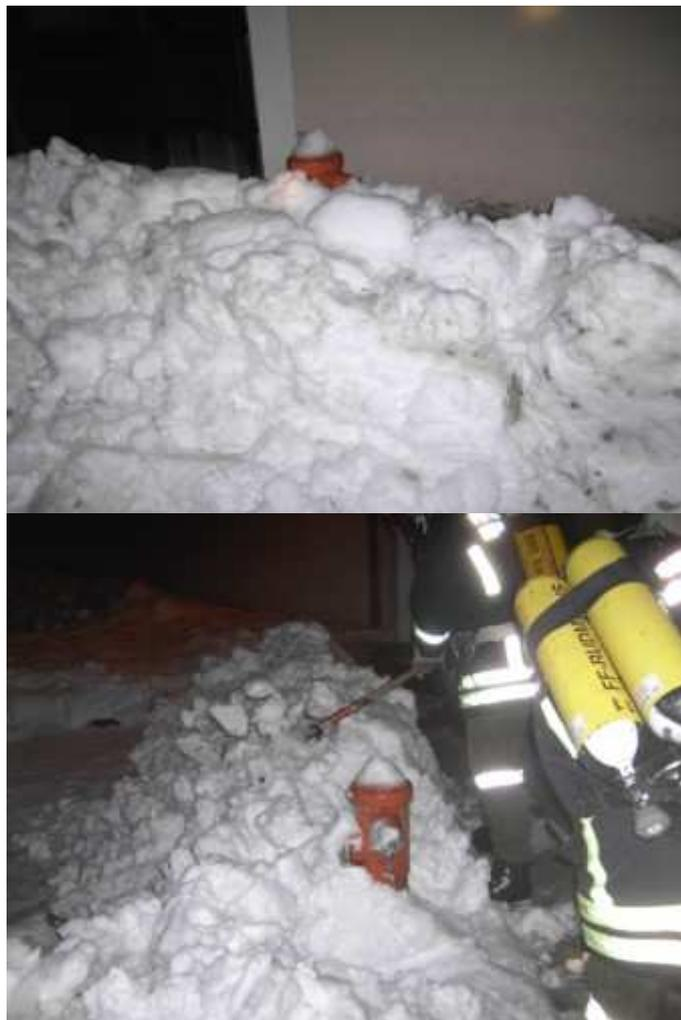
Aus diesem Überflurhydrant wäre bald ein Unterflurhydrant geworden, vielleicht könnte der Schneeräumer künftig diesen nicht so gut "einpacken" schließlich sollte er im Einsatzfall nicht nur gefunden, sondern auch bedient werden können
