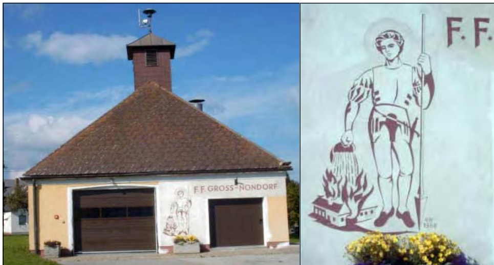
Das bis in das Jahr 2007 bestehende Feuerwehrhaus mit dem Bild des Heiligen Florian auf der Vorderseite.
