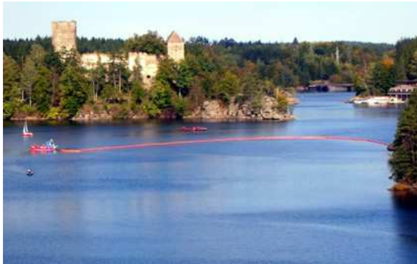
Die mittlerweile eingetroffenen Boote errichten die Ölsperren
