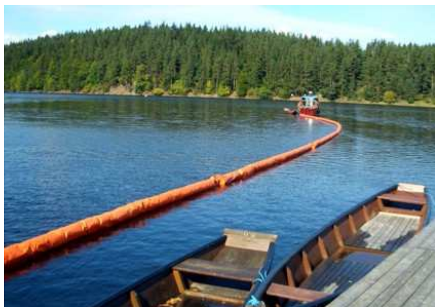
Mit den 200 m Ölsperren ging's ab Richtung Stauseebrücke
