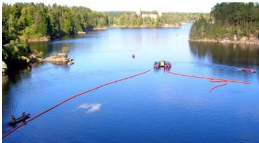
Die mittlerweile eingetroffenen Boote errichten die Ölsperren
