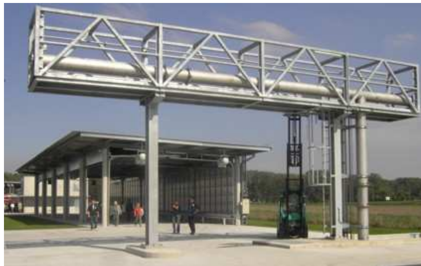
Rohrbrücke, dahinter Übungs-Straße bzw. -Tunnel
