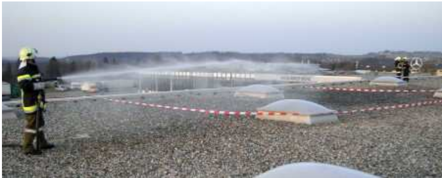
Brandbekämpfung auf dem Flachdach. Hinaufbefördert wurden wir mit dem Kran der FF Zwettl
