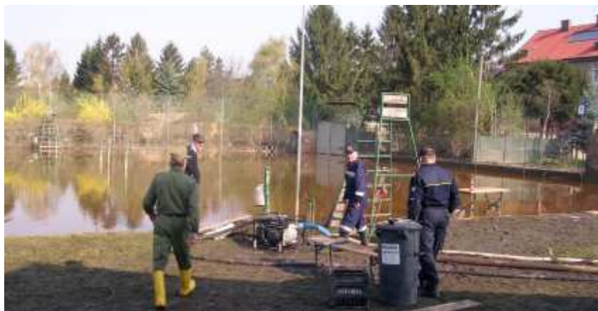
... und Tennisplatz werden "entwässert"
