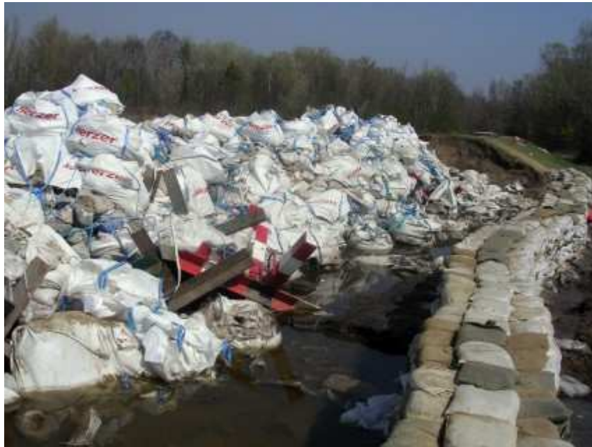
Der gebrochene Damm bei Jedenspeigen wurde durch eine Unmenge an Big-Bags, Panzersperren und Sandsäcke vor ca. 2 Wochen notdürftig geschlossen,...
