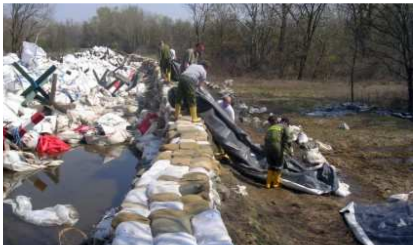
Der 2. KHD-Zug entfernte die nun nicht mehr notwendigen Hochwasserschutz-Planen
