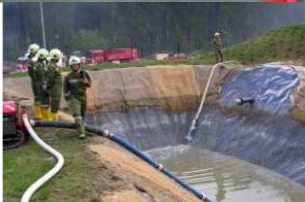
Die fast 3 km lange Leitung liefert zwar Wasser, wäre jedoch allein zu wenig
