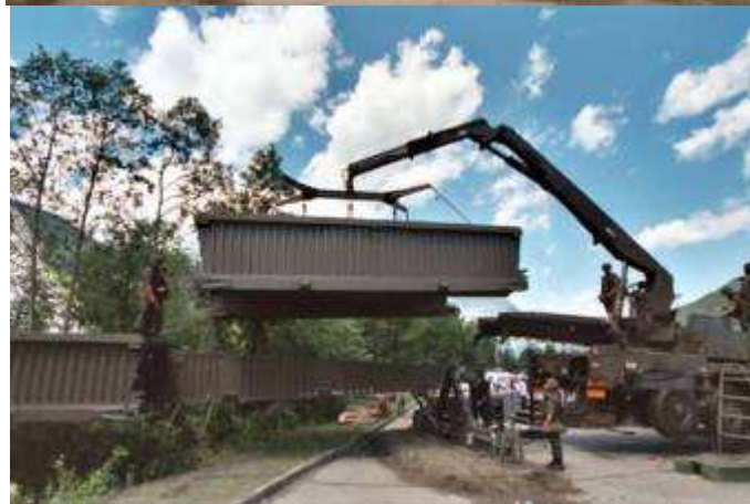
Bundesheer beim Errichten der Pionierbrücke 2000 über die Ill
