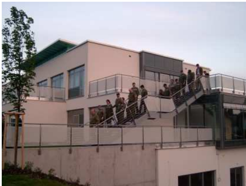
Einer der Fluchtwege im Evakuierungsfall
