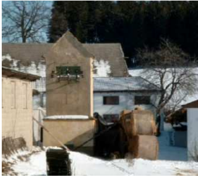
Das zu sprengende Objekt...
