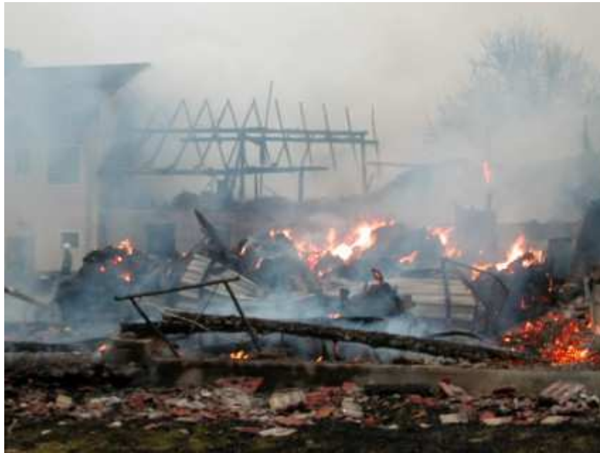
Das Wirtschaftsgebäude wurde ein Raub der Flammen
