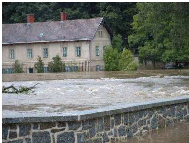
Das Wasser stieg nicht mehr ganz so hoch wie vor einer Woche, wie am Haus erkennbar
