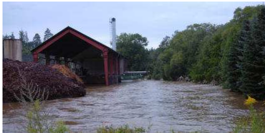
Auch die Heizung ging wieder "baden",...
