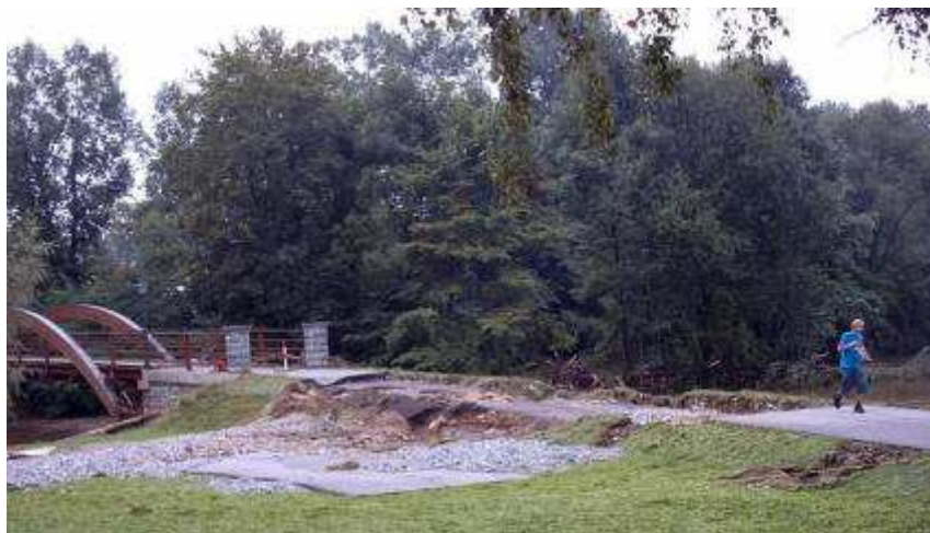
Die Asphaltdecke beim Rad- u. Gehweg wurde "abgedeckt"
