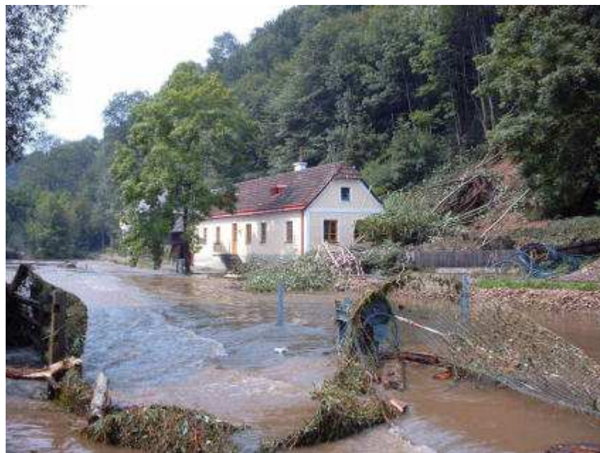
Dieses Haus wurde durch eine Mure gefährdet, hatte jedoch noch Glück
