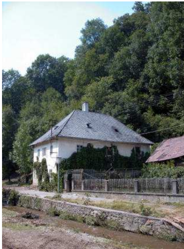
Aus diesem Haus musste Frau R. über die steile Böschung gerettet werden, der Wasserstand war allerdings einige Meter höher (bis ca. 30 cm unter der Erdgeschoßdecke)
