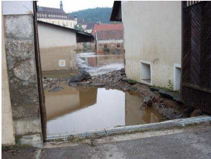
Die Einfahrt in den Meierhof wurde total ausgewaschen. An den dunklen Stellen auf den Mauern ist der Höchst-Wasserstand erkennbar
