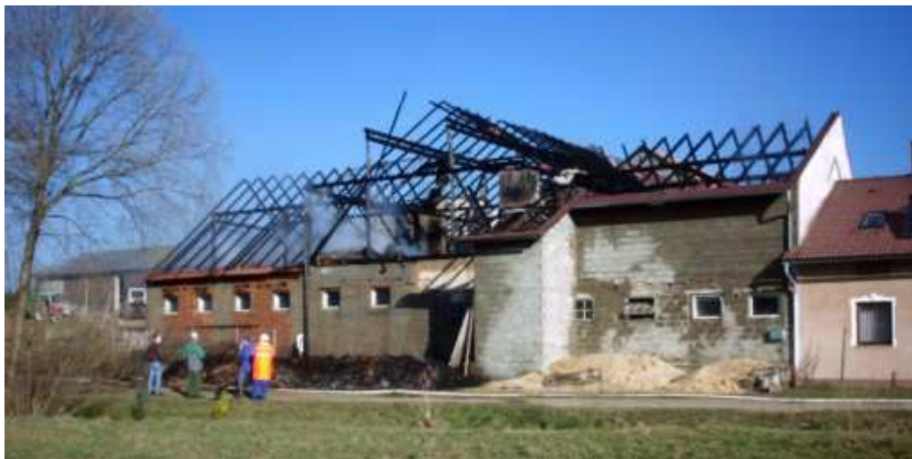
Das Brandobjekt am nächsten Tag mit den geretteten Nachbargebäuden
