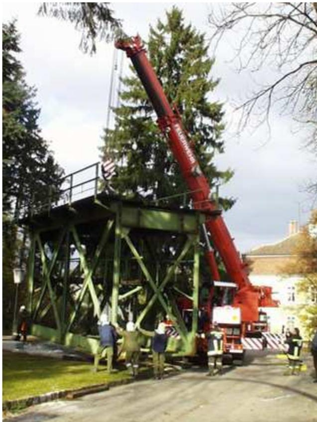
... und mit dem Kran der Feuerwehr auf die vorbereiteten Fundamente gehoben.
