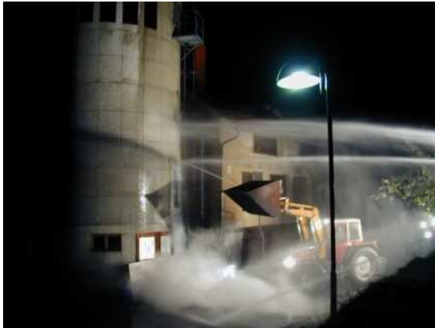
Auftauen der eingefrorenen Silotür
