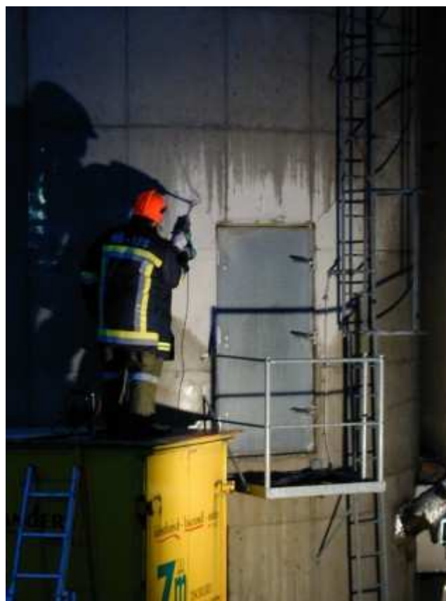
Der Silo wird angebohrt
