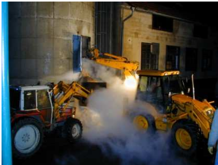
Ausräumen des Silos
