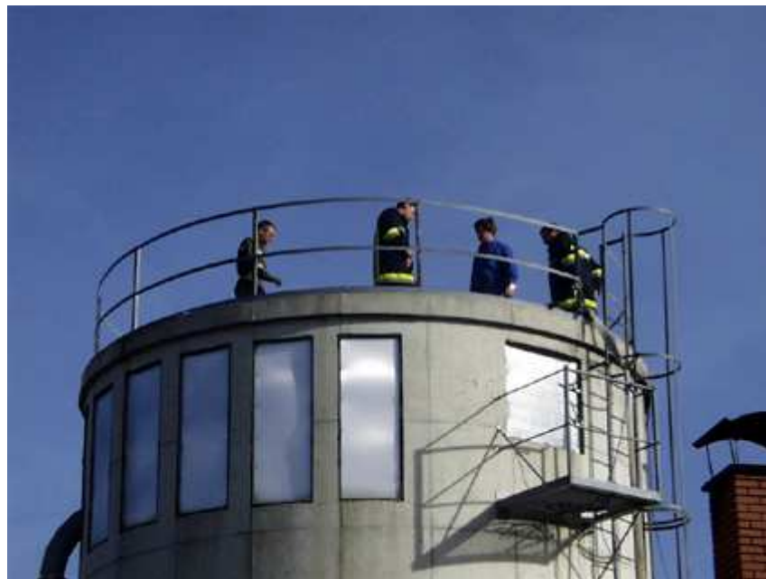
Messungen auf dem Silodach
