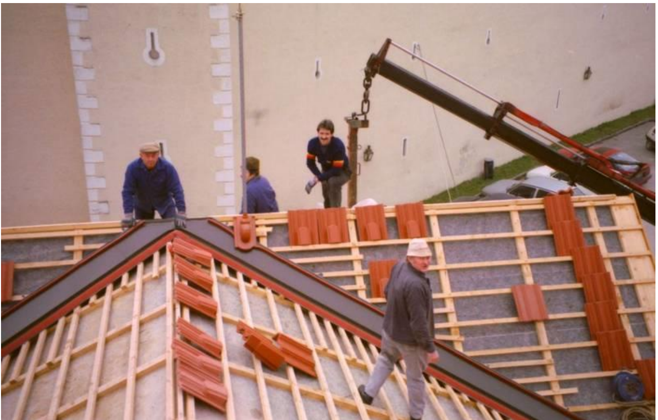
1994: Alois Kropfreiter (links) bei der Dachdeckung des FF-Hauses
