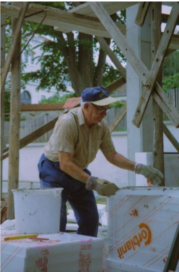
Alois Kropfreiter 1996 bei den Fassadenarbeiten
