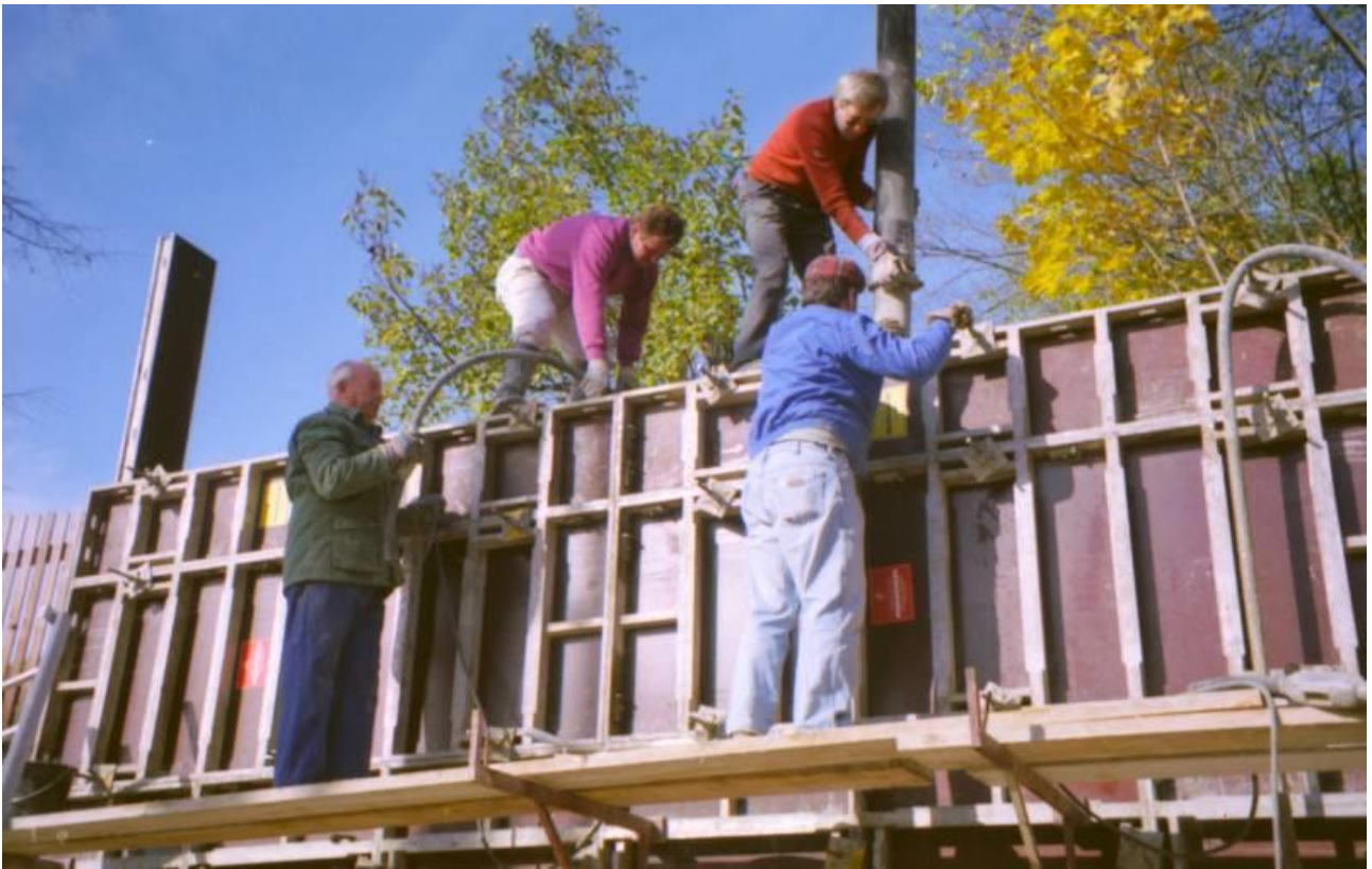
1994: Kropfreiter (ganz links) beim Bau des Feuerwehrhauses
