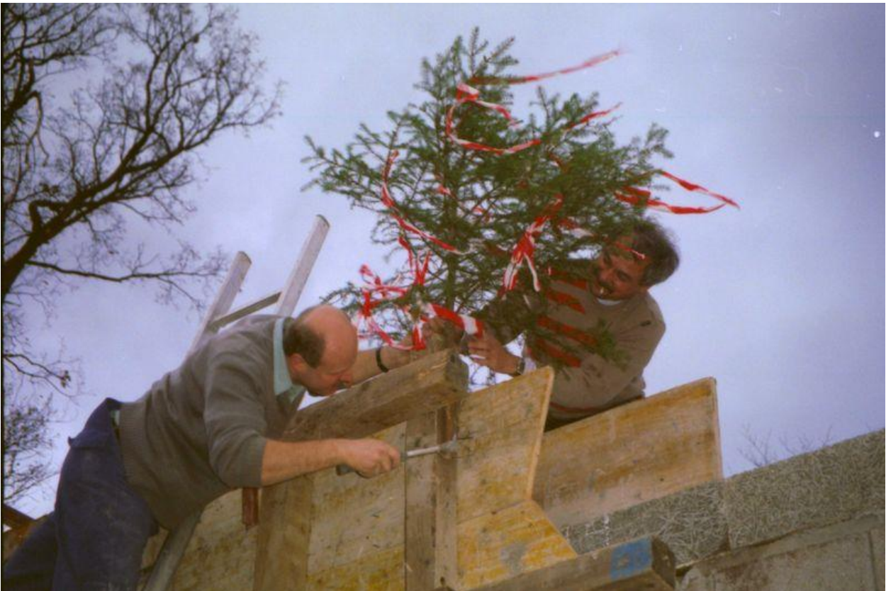
Almeder war auch gerne beim Feuerwehrhausbau tätig, hier bei der Rohbaugleiche 11/1994...
