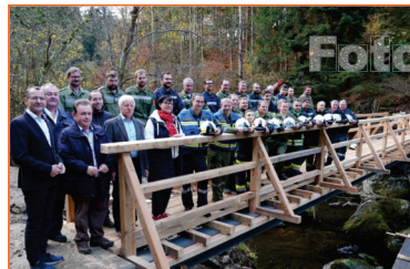
KHD-Zug baut Brücke, FF Moidrams Okt. 2022
