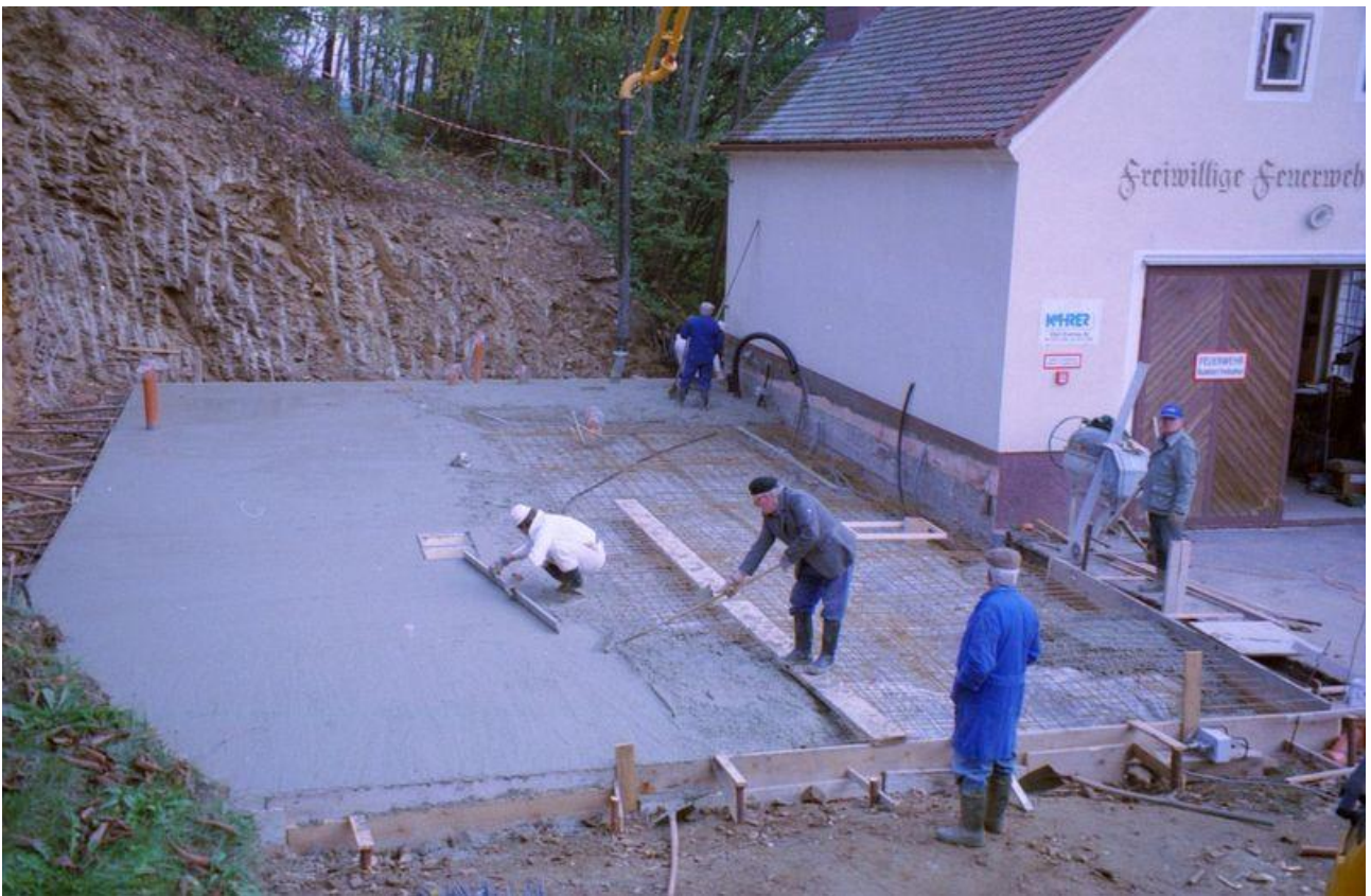
Alfred Kastl im Sept. 1994 beim Betonieren der Fundamentplatte des Feuerwehrhauses (mit Alois Kropfreiter, Johann Schmidt und Leopold Bruckner).
