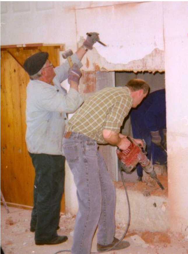
1995 beim Durchbruch zwischen altem Haus und neuem Feuerwehrhauszubau.
