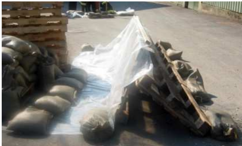
provisorische Hochwasserschutzwand
