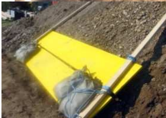
Herstellen einer Dammbabdichtung
