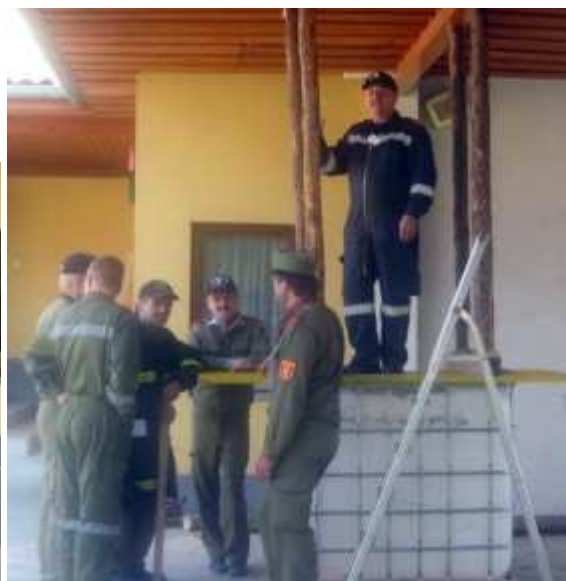
Pölzungen und sichern eines Heizöltanks gegen Aufschwimmen
