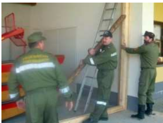
Pölzungen und sichern eines Heizöltanks gegen Aufschwimmen
